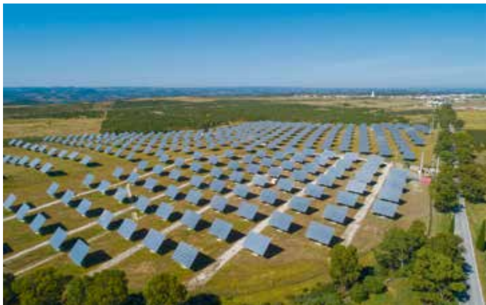
Central Fotovoltaica de Martim Longo | Maio de 2020
