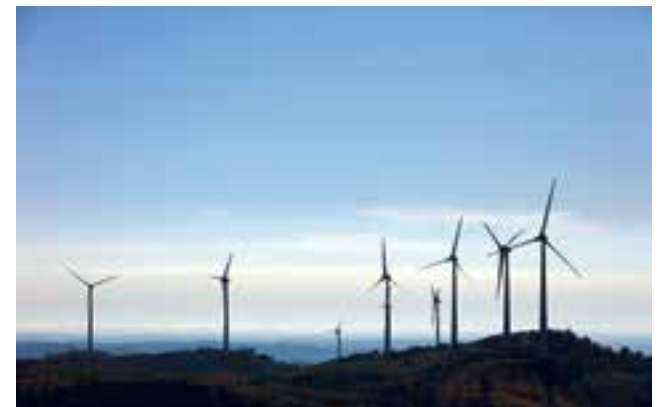
Parque Eólico do Malhanito, Cachopo (ENERCON) Serra de Tavra | Junho de 2020
