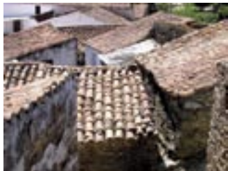
Coberturas inclinadas de telha de canudo. Beliche de Cima, Tavira. fotografia Miguel Reimão Costa
