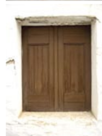
de cima para baixo Janela (tipo A) de taipal de madeira, de duas folhas. Cachopo, Tavira. fotografia Vítor Ribeiro; Janela (tipo B) de duas folhas com postigo, sem vidro, encerrado por portada interior. Martinlongo, Alcoutim. fotografia Vítor Ribeiro
