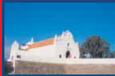
Consolidação de Muros de Suporte da Fortaleza da Bordeira
