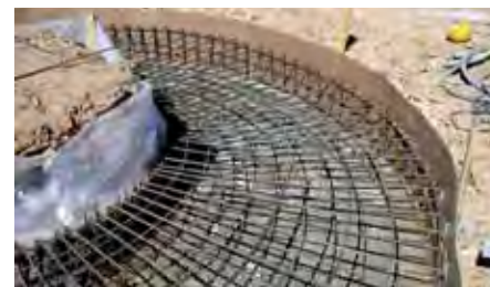
figura 213 Execução da sapata de fundação Sílvia Bento
