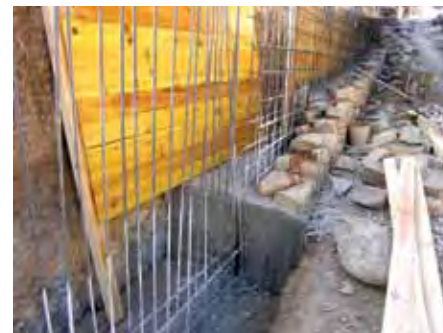
figura 349 Construção do muro de suporte misto de alvenaria de xisto e betão armado fSM
