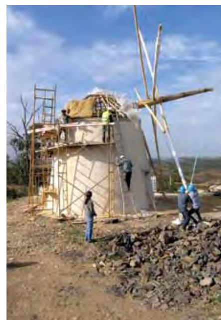
figura 217 Vista geral em fase de conclusão f S M
