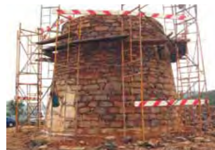
figura 216 Alvenaria de xisto em fase de conclusão f GTAA
