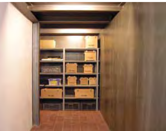
figura 274 Sala de arrumos no novo volume (compartimento 11) f S M
