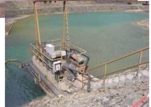
BAC3: capacidade de armazenamento  $5000\text{m}^3$ , utilizada para retenção das águas pluviais geradas na área dominada pelas E1A e E1B, as quais são encaminhadas por bombagem para a B. Cerro do Lobo.
