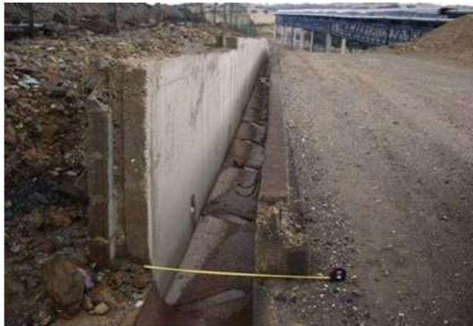
Vala com secção retangular (1,40x0,5x0,80), em que os muros têm altura diferente
