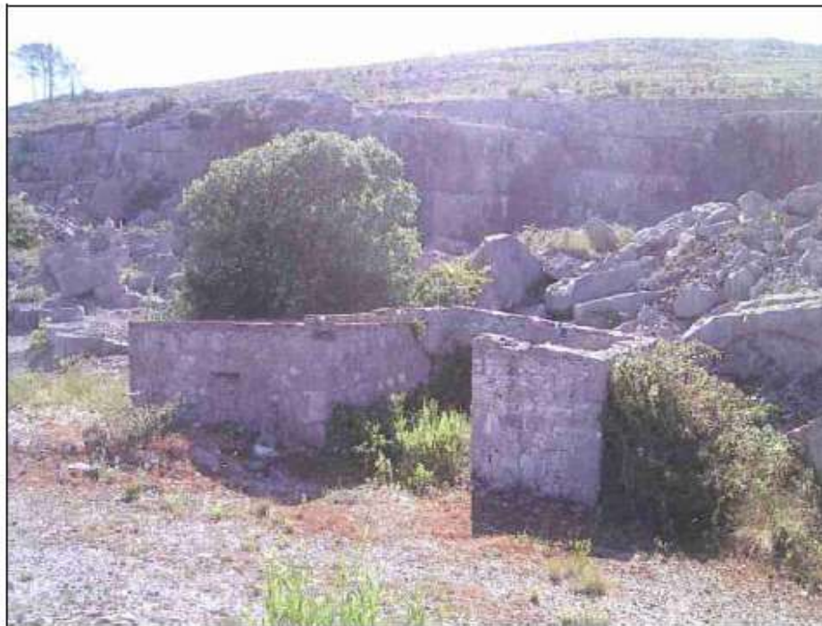
Infra-estruras em ruínas
