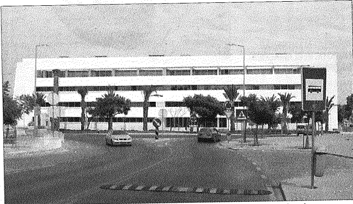
Câmara de Lagos vai avançar com diversas obras que vão permitir desativar fossas sépticas ainda em funcionamento
