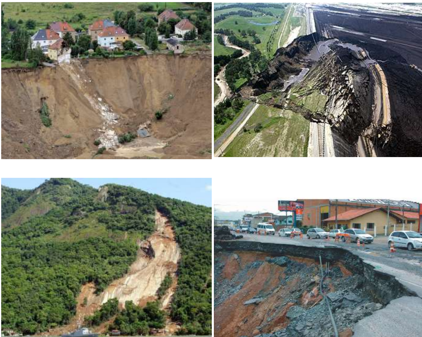
Figura 32. Instabilidade das vertentes com prejuízo para pessoas e bens. ( www.google.com )
