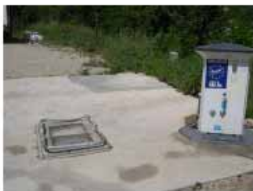
Fig. 16. Equipamento de apoio (Amélie e Sur Les Bains)
