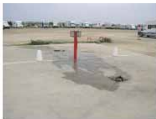
Fig. 11. Área de serviço (Gruissan - Marina)
