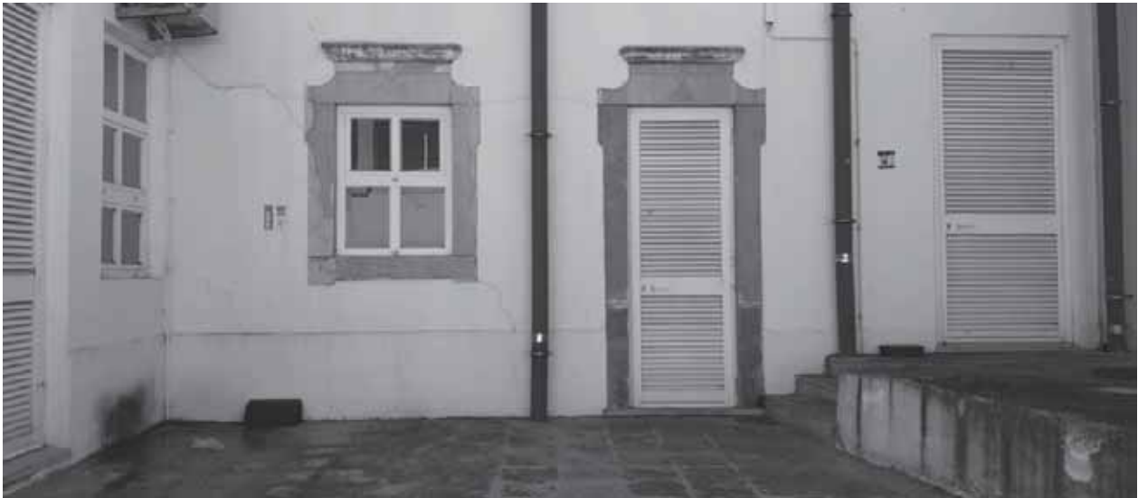
Fig. 10 - Dois vãos da casa rural, com guarnições em cantaria, conservados na fachada tardoz. Vítor Ribeiro, 2021.
