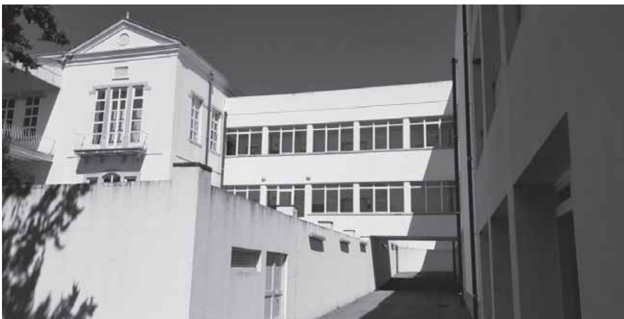
Fig. 16 - Corpo de ligação entre o edifício original e a ampliação executada nos anos 1960. Vítor Ribeiro, 2021.
