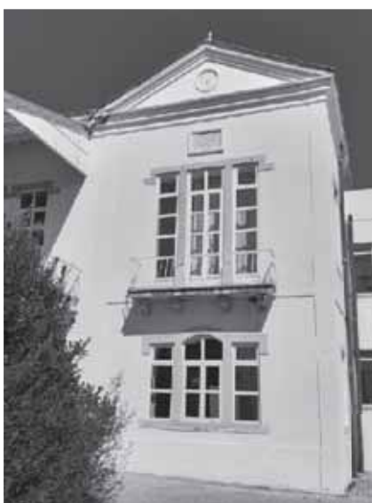
Fig. 9 – O torreão do SCVP evocativo da casa rural preexistente. Vítor Ribeiro, 2021.
