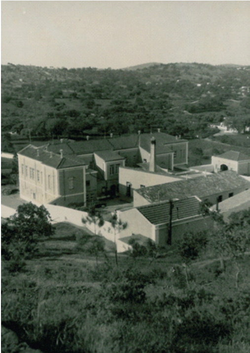
Fotografia 1 – Sanatório S. Brás de Alportel, vista geral, s/d. Arquivo Privado.
