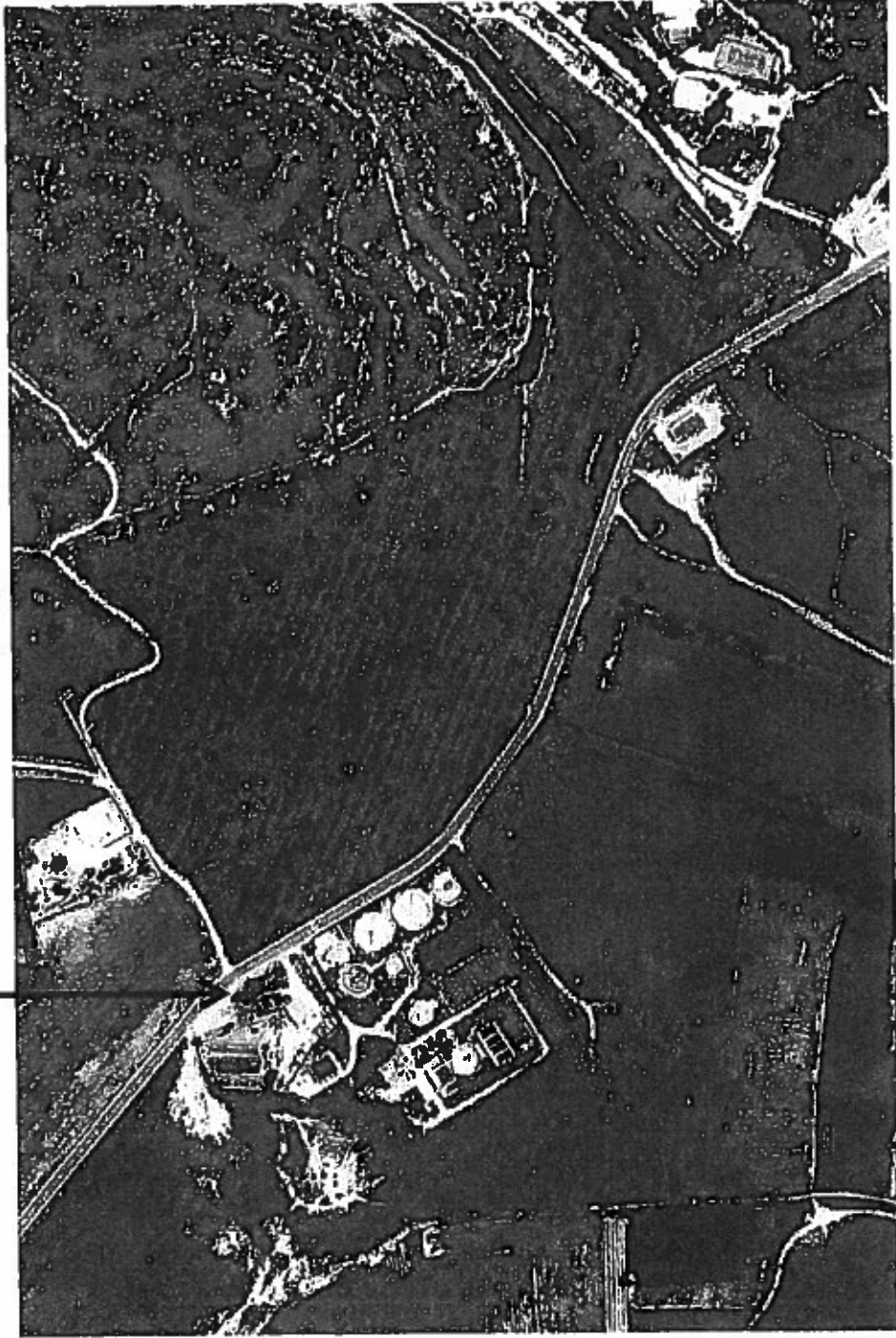
Ponto de entrega do efluente na infraestrutura da AdA
